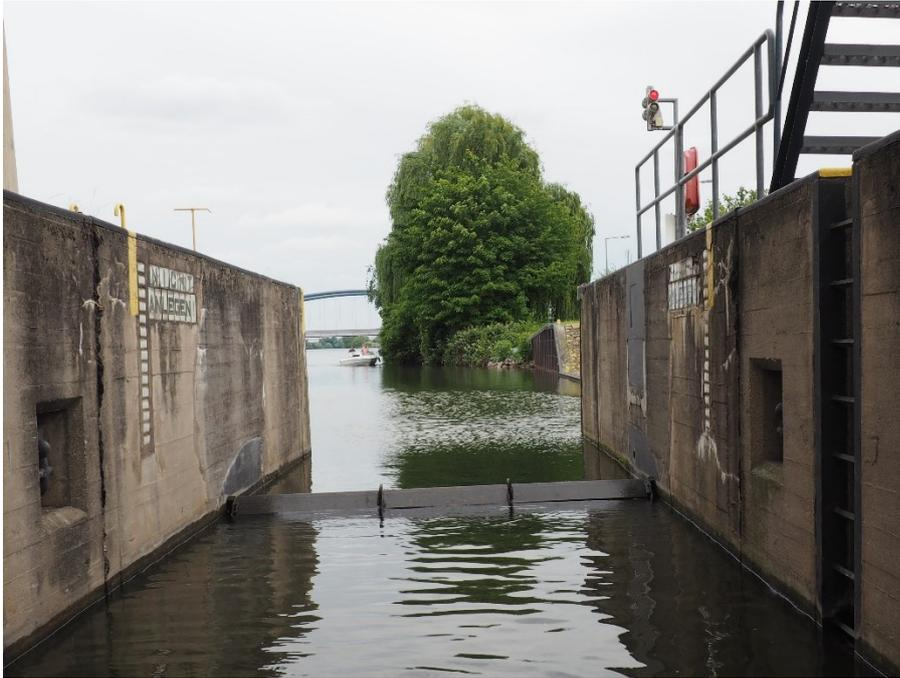
Hier taucht gerade das bergseitige Schleusentor aus dem Wasser auf. An der rechten und linken Schleusenmauer weisen gelbe Farbmarkierungen auf den Grenzbereich hin, in dem sich ein Boot während der Schleusung innerhalb der Kammer aufhalten darf. Die bergseitige Begrenzung zeigt das Ende des Drempels an. Talseits ist es der Raum, den das
