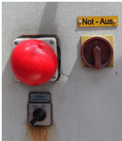
Mit dem unteren Hebel wird eingestellt, ob die Schleusung zu Berg oder zu Tal erfolgt. Dann muss während der Schleusung nur noch der rote Buzzer gedrückt werden. Den Not-Aus haben wir nicht benötigt.
